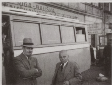
ARNOLDS SPEKKE un EDVARTS VIRZA pie Rīgas-Bauskas autobusa
