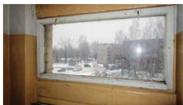
Viestura ielas 14.mājas kāpņu telpu logi ir bēdīgi stāvoklī, tāpēc tiem nepieciešama nomaiņa
