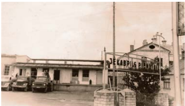
Jēkabpils piena kombināts pēc rekonstrukcijas. 1970. gads
