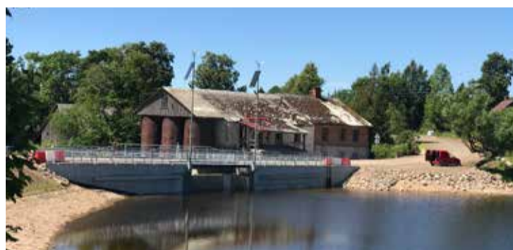
Uz ceļa posma “Jaunteteri – Jumpravmuiža – Virbotnes” tilts pirms un pēc pārbūves veikšanas.
