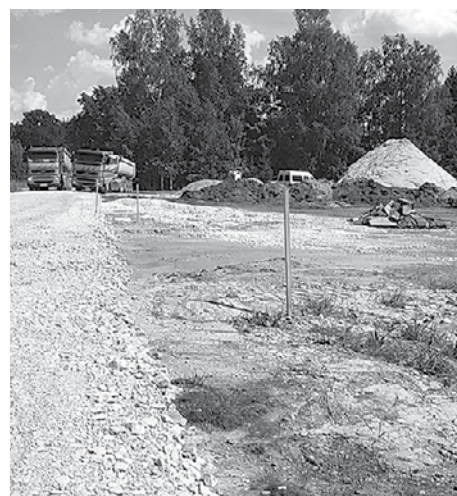
Vārpu ceļa Dzilnuciemā pārbūve.
