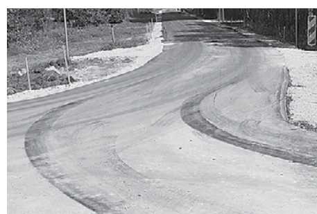
Vārpu ceļa Dzilnuciemā pārbūve.
