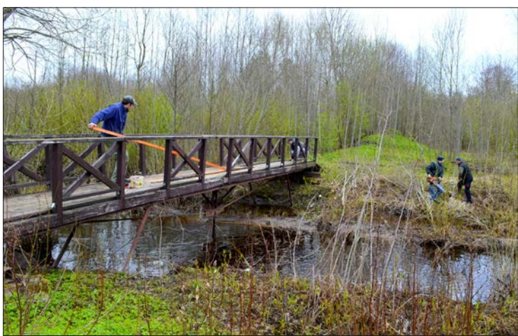
Tiek labots tilts pār Pelnupi, kā arī no krūmiem tiek attīrīti upes krasti.
