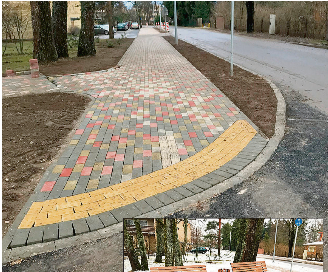
Foto no domes arhīva
