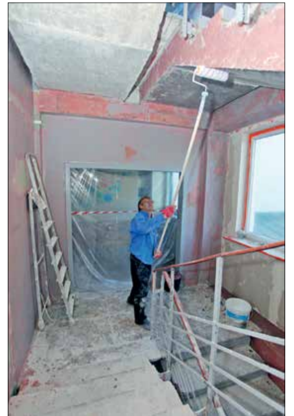
Jelgavas 5. vidusskolā šovasar notiek centrālo kāpņu remonts – tiek mainīti pakāpieni un kāpņu margas. Vizuālas pārmaiņas visu stāvu garumā piedzīvo arī kāpņu telpa, kur tiek īstenoti sienu apdares darbi un ierīkotas bīdāmās durvis. Jelgavas Izglītības pārvaldes pārstāvis Andris Baltais stāsta, ka šī ir pirmā kāpņu telpas rekonstrukcija kopš skolas uzcelšanas 20. gadsimta 70. gadu sākumā, kas skolēnu un mācībspēku pārvietošanos ikdienā padarīs ērtāku un drošāku.
