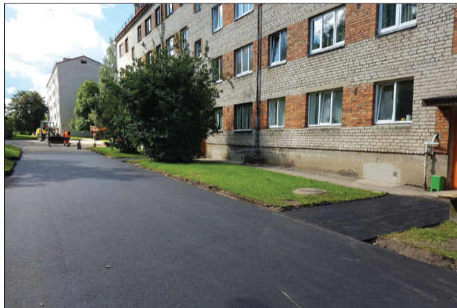
← A. Pumpura ielas 10 iedzīvotāji ar pašvaldības līdzfinansējumu mājas pagalmā uzklāja jaunu asfaltbetona segumu.
