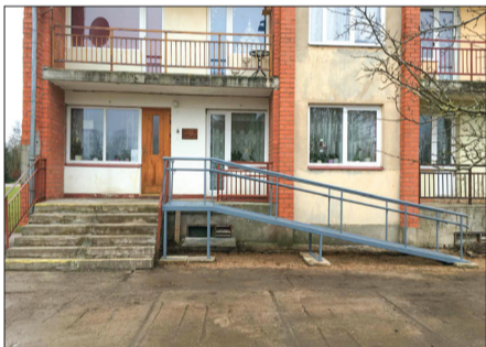
Pie ģimenes ārsta prakses uzstādīta uzbrauktuve.
