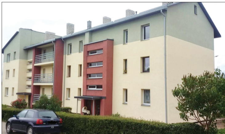
Nosiltinātā ēka Valdemārpilī, Parka ielā 3
