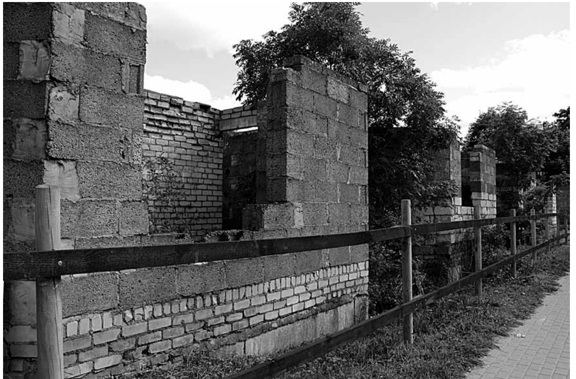
Ap nepabeigto būvi Virkas ielā 3 tiek celts pusotru metru augsts žogs.
