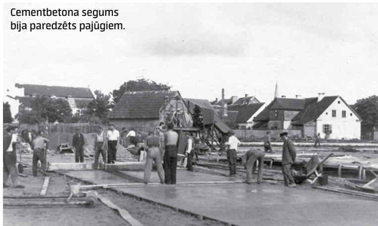
Kā pirms 80 gadiem rakstīja Jaunais Kurzemnieks , asfaltbetona segums tika klāts uz 18 cm biezas akmens šķembu kārtas.
