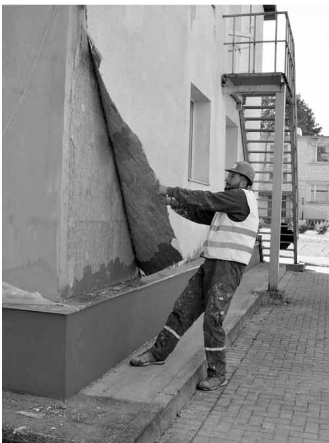
Kuldīgas uzņēmuma Lexa ID celtnieks Artūrs Gercs rāda, ka Nīkrāces saieta namam viss iepriekšējais apšuvums jānoārdā.
