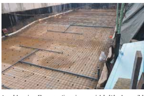
Jaunā baseina dibens ar stiegrojumu un iebūvētām komunikācijām pirms betona ieliešanas. 2016. gada 11. jūlijs.
