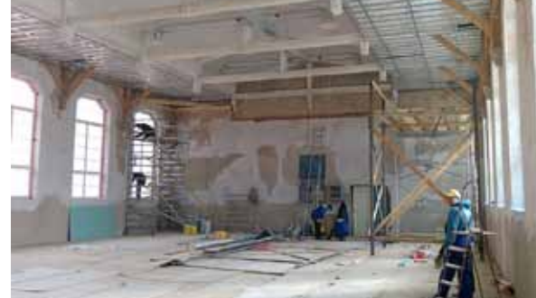
Sākta sporta zāles atjaunošana – tiek mainīts viss, izņemot sienas un jumta nesošās konstrukcijas, tās pastiprinātas ar speciālām detaļām. 2017. gada 13. marts.
