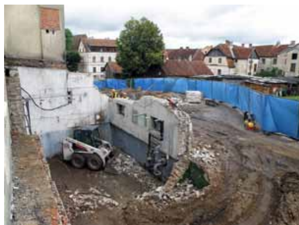
Nojaukta sporta skolas vecā ieeja, sāks rakt baseina būvbedri. 2015. gada 2. septembris.
