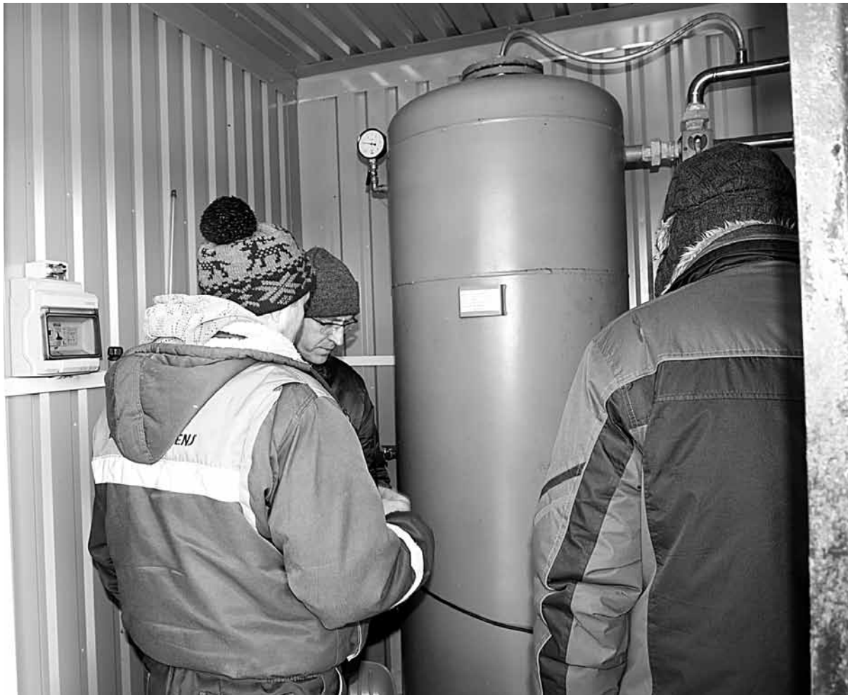
Kuldīgas ūdens darbinieki apskata Vilgāles ciema dzeramā ūdens atdzelzošanas iekārtu.
