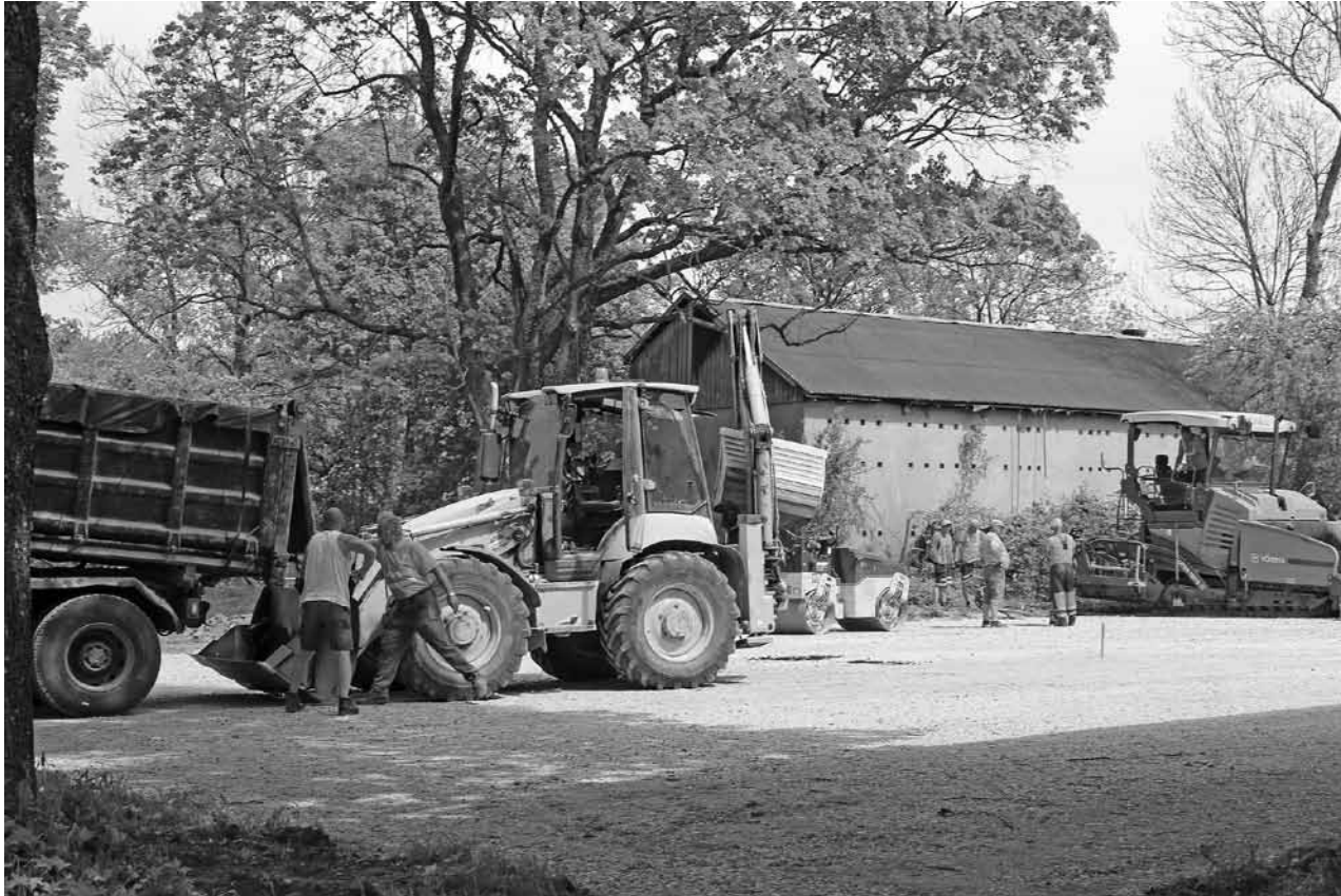
Kuldīgā, Pētera ielā, pie Mākslas un humanitāro zinību vidusskolas šovasar taps dažādu sporta veidu laukums. Piektdien SC Kuldīga viri to asfaltēja.
