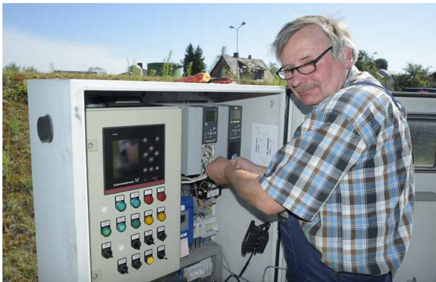
Kuldīgas ūdens elektriķis Imants Grundmanis ūdensapgādes sistēmai pievieno no Dānijas atsūtīto iekārtu – frekvenču pārveidotāju.
