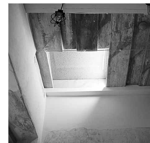
Te var redzēt veco siltinājumu starp pārsegumiem: dēļus, sūnas, mālus. Mūsdienu pienesums ir ekoloģiskā vate.
