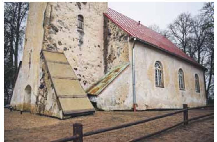
Īvandes luterāņu baznīcā pamati atrakti, mazgāti, noklāti ar hidroizolācijas membrānu, uzlabota lietūsūdens sistēma, iebūvētas astoņas skatakas, nedaudz remontēts balsta pīlārs.
