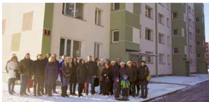
Meža iela 7 ir pirmā māja, kura renovēta ar SIA “Salaspils Siltums” dalību.
