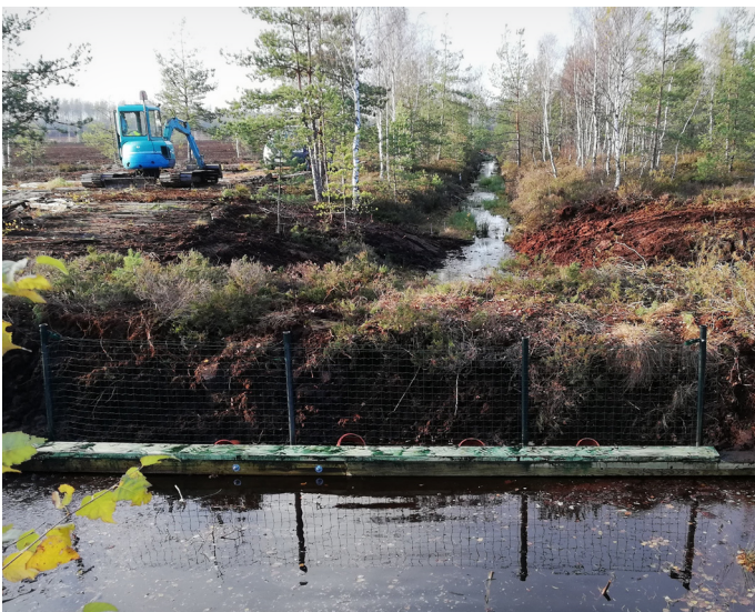
Viens no trīs izbūvētajiem inovatīvajiem kūdras dambjiem uz notekgrāvjiem gar dabas liegumu, lai ilgtermiņā nodrošinātu dabas vērtību saglabāšanu
