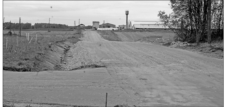
Идут подготовительные работы на автодороге самоуправления № 15 Опуги – Рунцавниеки.
