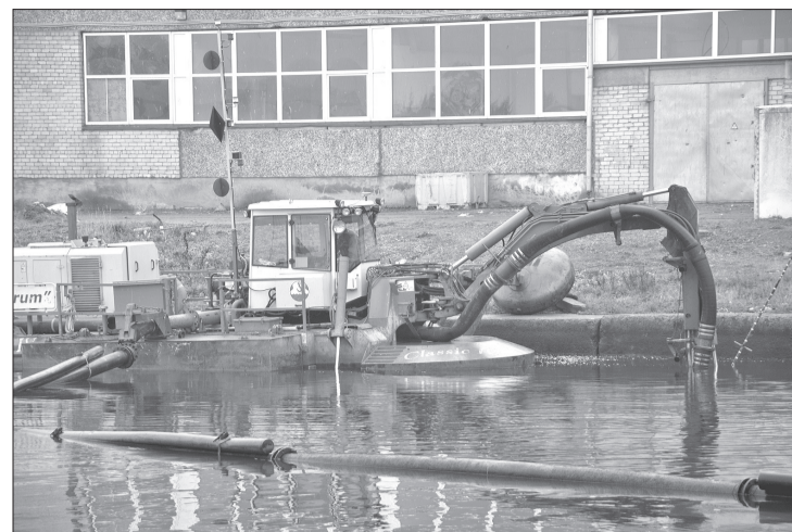
Šobrīd notiek ostas iekšējā kanāla padziļināšana.
