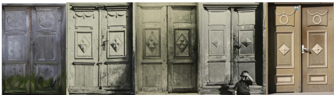
30., 31., 32., 33. un 34. attēls. Trīsdalījuma ārdurvju vērtņu pāris Aizputē, sētas mājai Jāņa ielā 10 (SO), trīs neidentificētām ēkām (VKPAI) (nav saglabāts) un Grota namam Atmosdas ielā 31 (SO)
