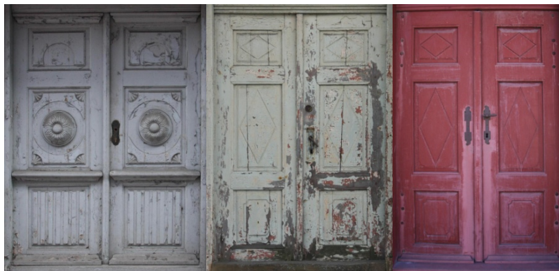
11., 12. un 13. attēls. Rāmja konstrukcijas trīsdalīguma ārdurvju vērtņu pārisdzīvojamai ēkai Kuldīgā, Skrundas ielā 14 (SO), Ventspilī, Lielajā ielā 16 (SO), Akmeņu ielā 5 (SO) un Audēju ielā 15 (SO)
