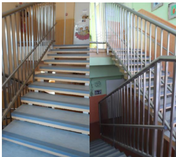
97. attēls. Atjaunotas trepes uz otro stāvu
