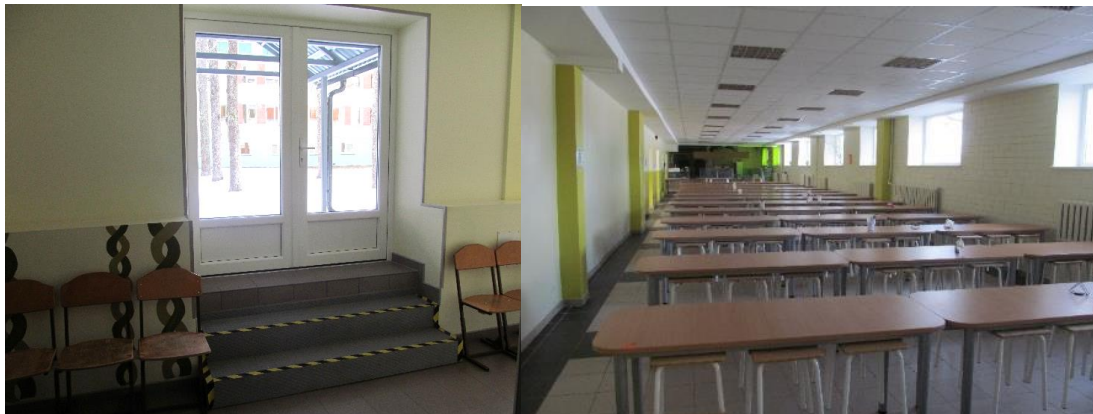
75. attēls. Skolas ārdurvis un ēdamtelpas pēc rekonstrukcijas
