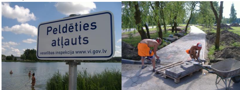
30. attēls. Bruģa seguma uzlikšana un peldvietu iekārtošana
