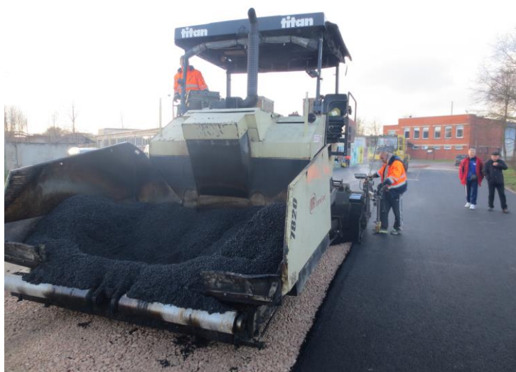
32. attēls. Asfaltbetona uzklāšana
