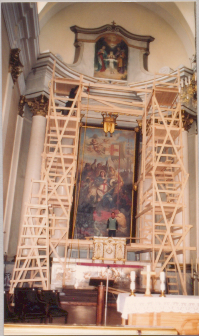
Fot. 9 Budowa rusztowań przy ołtarzu gł.
