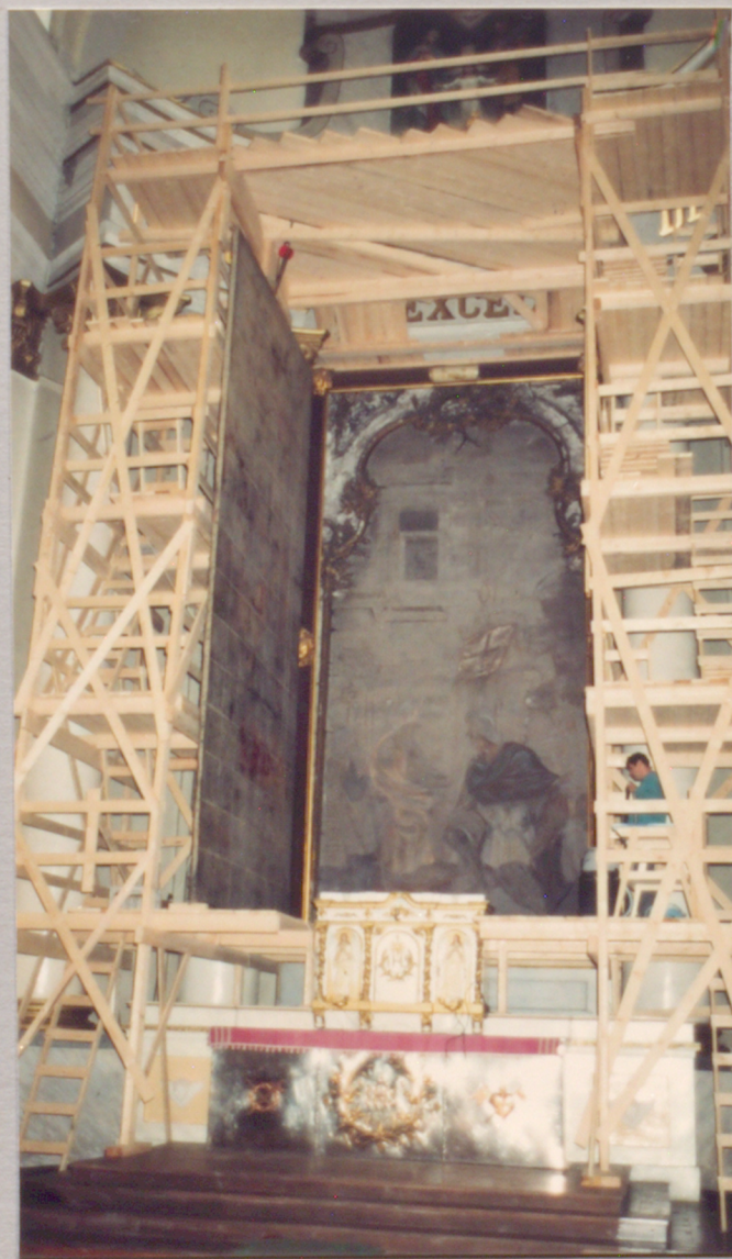
Fot. 12 Po odsłonięciu malowidła ściennego „ św. Ludwik.”
