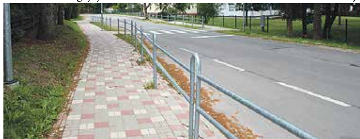
Gājēju ietvi plānots izbūvēt no Pļavniekkalna sākumskolas līdz autoceļam V2.
