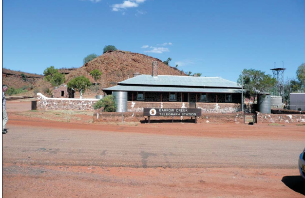
12. att. Vēsturiskā Barrovkriķas ( Barrow Creek ) telegrāfa stacijas ēka, kas būvēta 1872. gadā.
