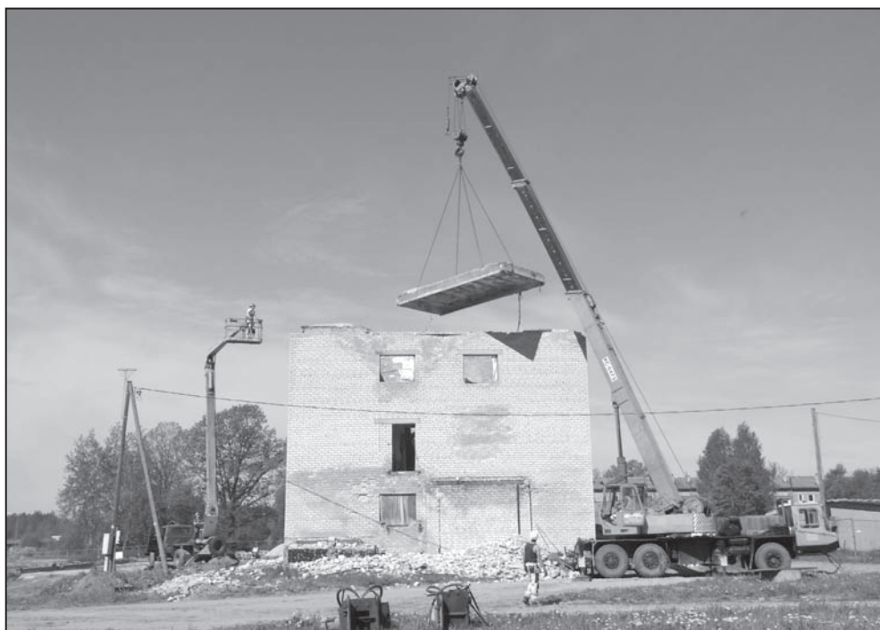
Uzsākti demontāžas darbi topošās Kārķu ražotnes teritorijā. Foto: Sandra Pilskalne
