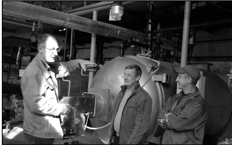
— Vīri, līdz apkures uzsākšanai vēl jāpabeidz dūmeņa rekonstrukcija, — atgādina A. Karpenko. Taču Dārzu ielas katlumājā padarītais — uzlabotais apgaismojums, balsinātie griesti un krāsotās sienas, izolētās caurules, labiekārtotā dušas telpa — apmierina gan katlumāju priekšnieku Aleksandru Kitovu un uzņēmuma arodbiedrības priekšsēdētāju Jāni Sluļevu.
