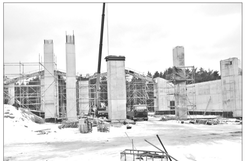
Vēl daži mēneši un šī celtniecības stadijā esošā celtnē būs kļuvusi par vienu no skaistākajām brīvdabas estrādēm Latvijā.
