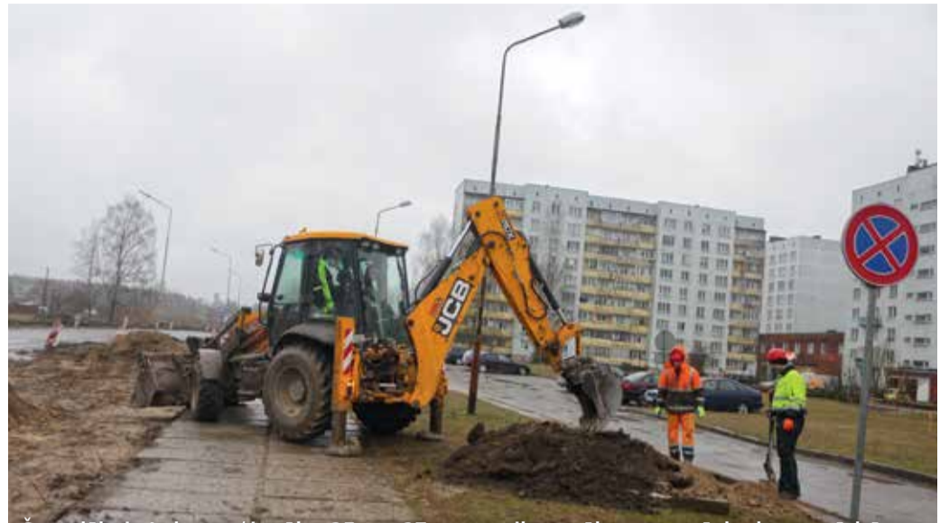
Šonedēļ pie Loka maģistrāles 25. un 27. nama tiks uzsākta autostāvlaukuma pārbūve – šajā laikā automašīnu stāvēšana norādītajā vietā būs aizliegta. Foto: Ivars Veilīns
