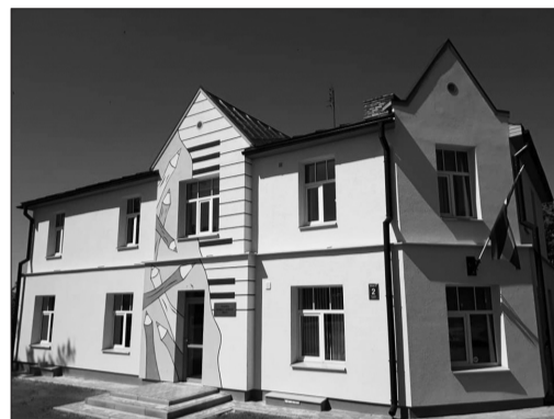
Rekonstruētā Līgatnes Mūzikas un mākslas skolas ēka Augšlīgatnē, Mākslas ielā 2. Egila Kurpnieka foto
