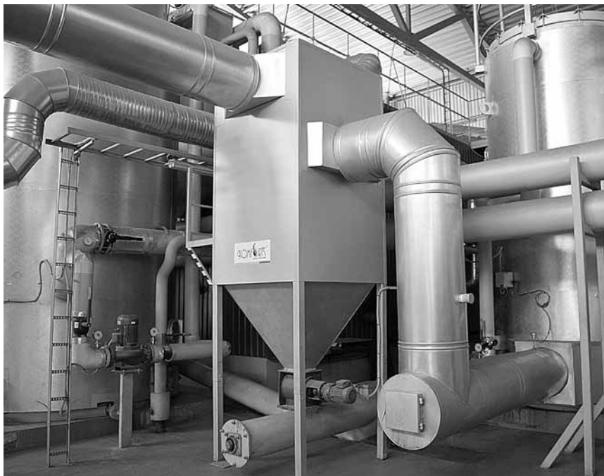
Kuldīgā siltumenerģija tiek ražota katlumājā Lapegļu ielā, kas strādā arī vasarā, lai piegādātu silto ūdeni.
