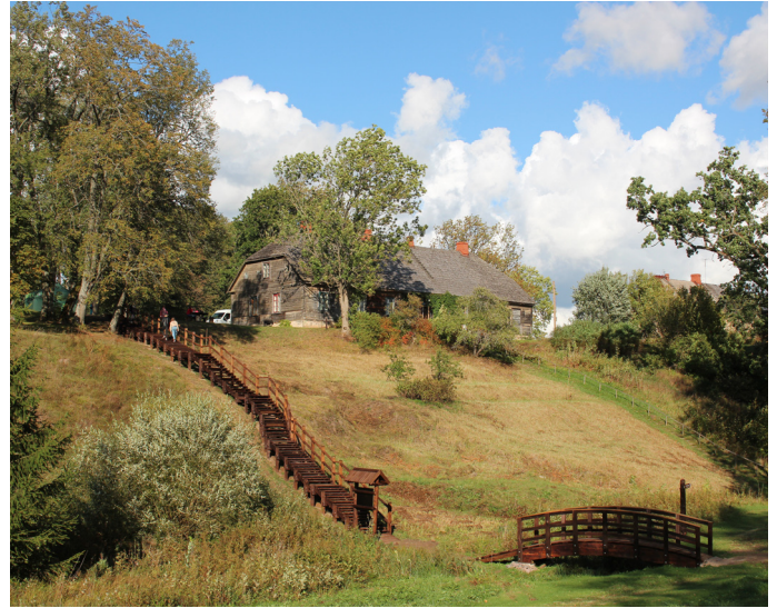
Projekta ietvaros apmeklētāju ērtībai atjaunotas kāpnes un gājēju tiltiņi, uzstādīti gandrīz 700 pakāpienu. Foto: A. Tabaks
