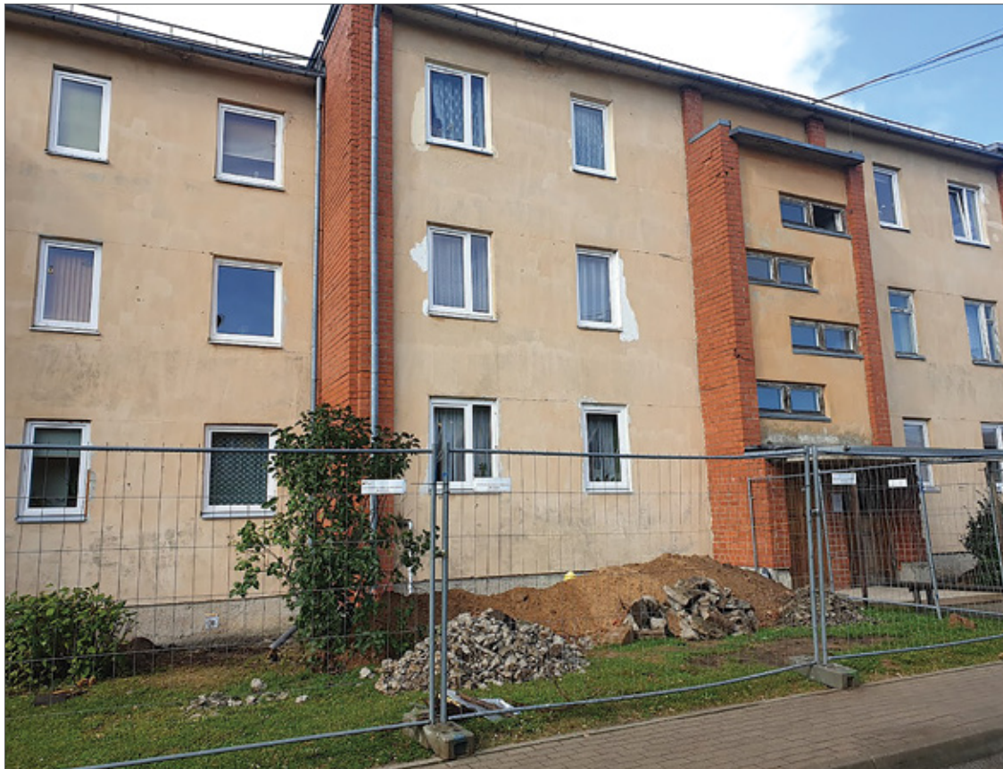
Daudzdzīvokļu dzīvojamā māja Ķekavā, Nākotnes ielā 8.
