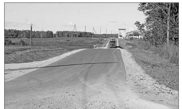
745 m sakārtota pašvaldības autoceļa Nr. 15 Opūgi–Runcavnieki.
