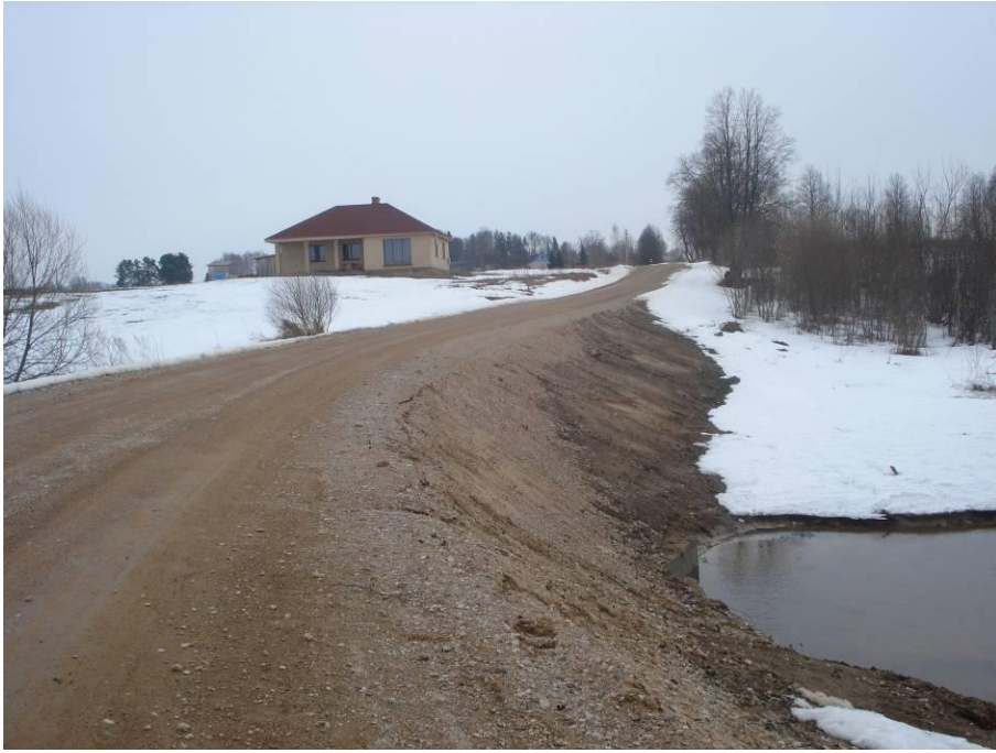
Demenes pagasta pārvalde, projekts „Demenes pagasta autoceļa ” Grobiņi – Jāņuciems” rekonstrukcija” 2,507km. Kopējās izmaksas Ls 47235,89.
