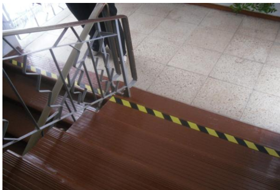
Kāpņu telpu remontdarbi
