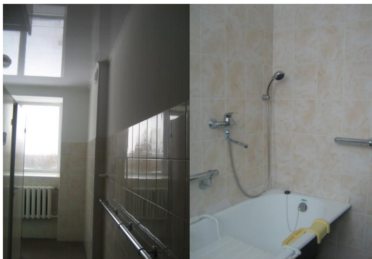
Sanitāro mezglu remontdarbi
