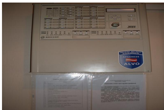
Ugunsdrošības signalizācijas iekārtas uzstādīšana
