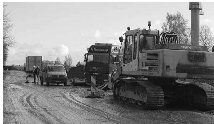
Noslēgušies lietus ūdens kanalizācijas-drenāžas sistēmas izbūves darbi Ķīmiķu ielā. Pašreiz notiek objekta nodošana ekspluatācijā. Darbu ietvaros izbūvēti arī pievadi privātmājām virsūdens novadīšanai.
