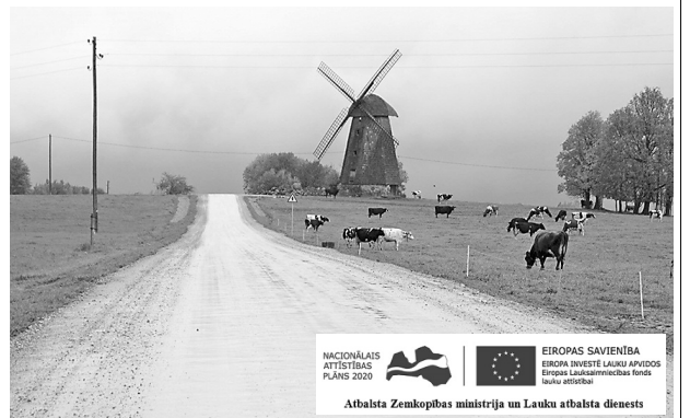
Pabeigti pārbūves darbi uz pašvaldības autoceļa Nr. 4 Stabulnieki–Pastari 3,43 km garumā.
