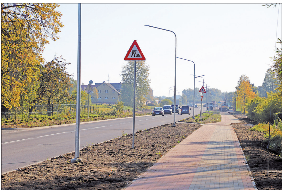
AUTOBRAUCĒJI, VELOSIPĒDISTI UN GĀJĒJI jau aktīvi izmanto rekonstruēto Jaunceltnes ielu.
