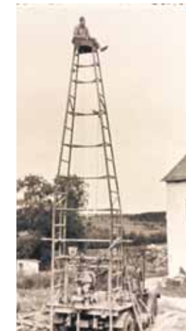
Artēzisko aku urbšanas agregāts AVB-3-100. Ar tādu Jānis Blūms strādāja no 1953. gada maija līdz 1959. gada februārim. Jānis sēž torņa galā Asares spirta brūzi. Hugo Briēža foto.
