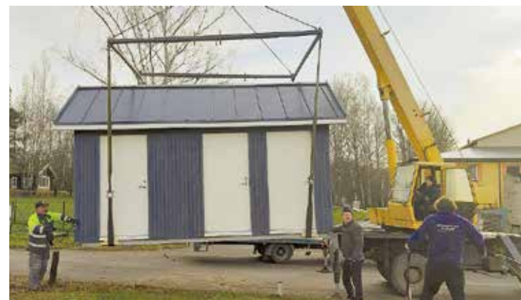
Tualetu bloka uzstādīšana.
