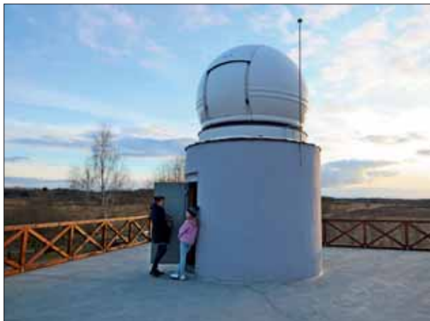
Observatorijas kupols un jumta platforma.
