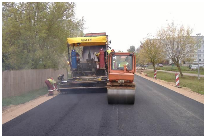
19. attēls. Asfalta seguma uzlikšana.
