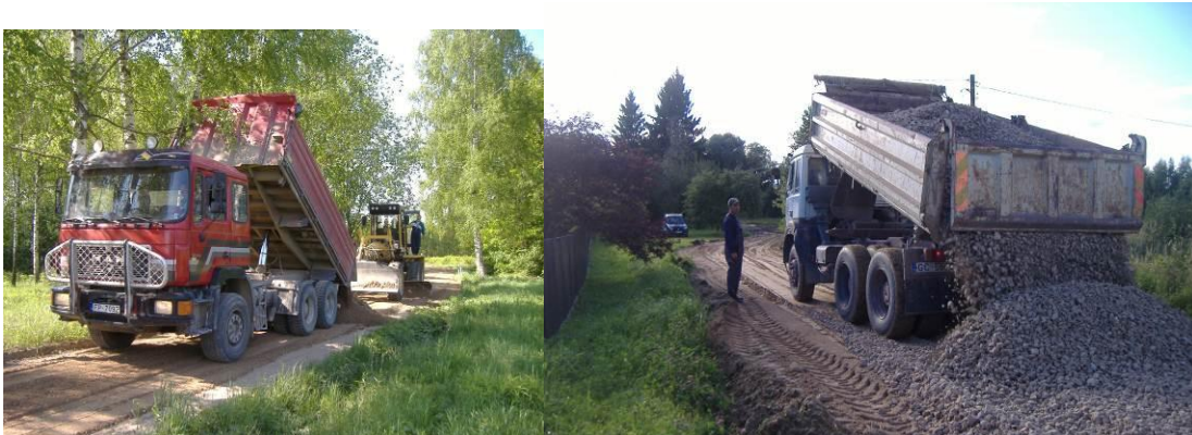
17. attēls . Ceļu segumu atjaunošana
