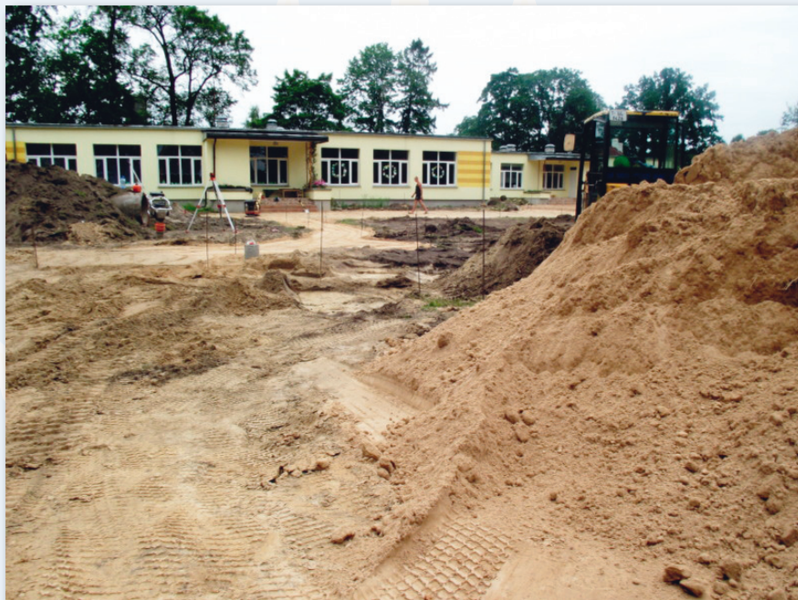
68. attēls. PII „Bītiņe” remontdarbu laikā
