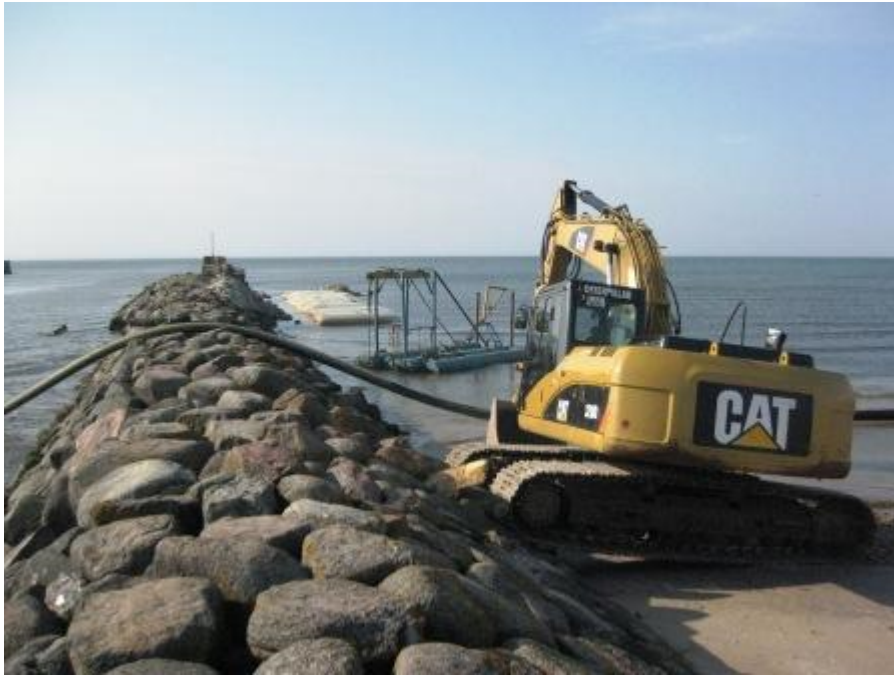
15.attēls. Pāvilostas ostas akvatorijas padziļināšanas darbi
