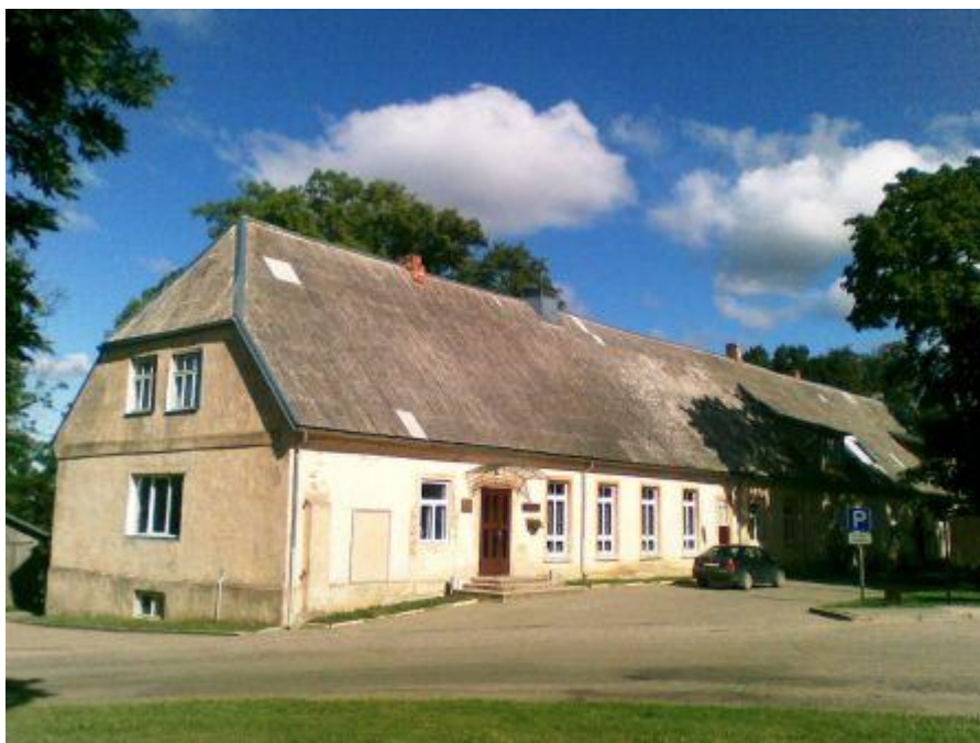
7.attēls. Vērgales kultūras nama ēkas gals, kuram paredzēts veikt jumta rekonstrukciju
