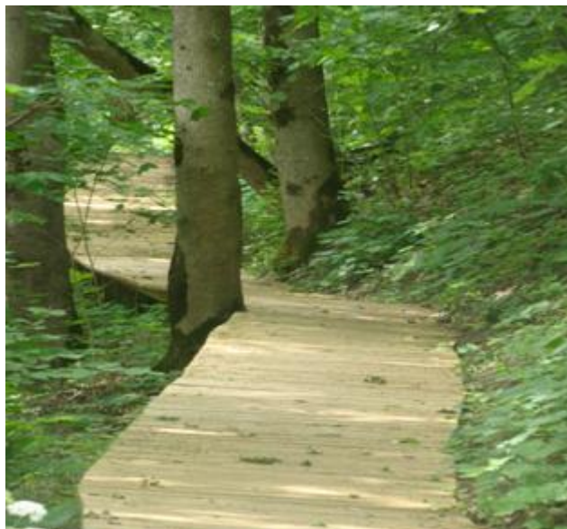
Jaunuzbūvētais pastaigu celiņš Mežotnes pilskalns – Vīna kalns
